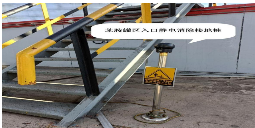
图 1 金属接地静电消除装置
